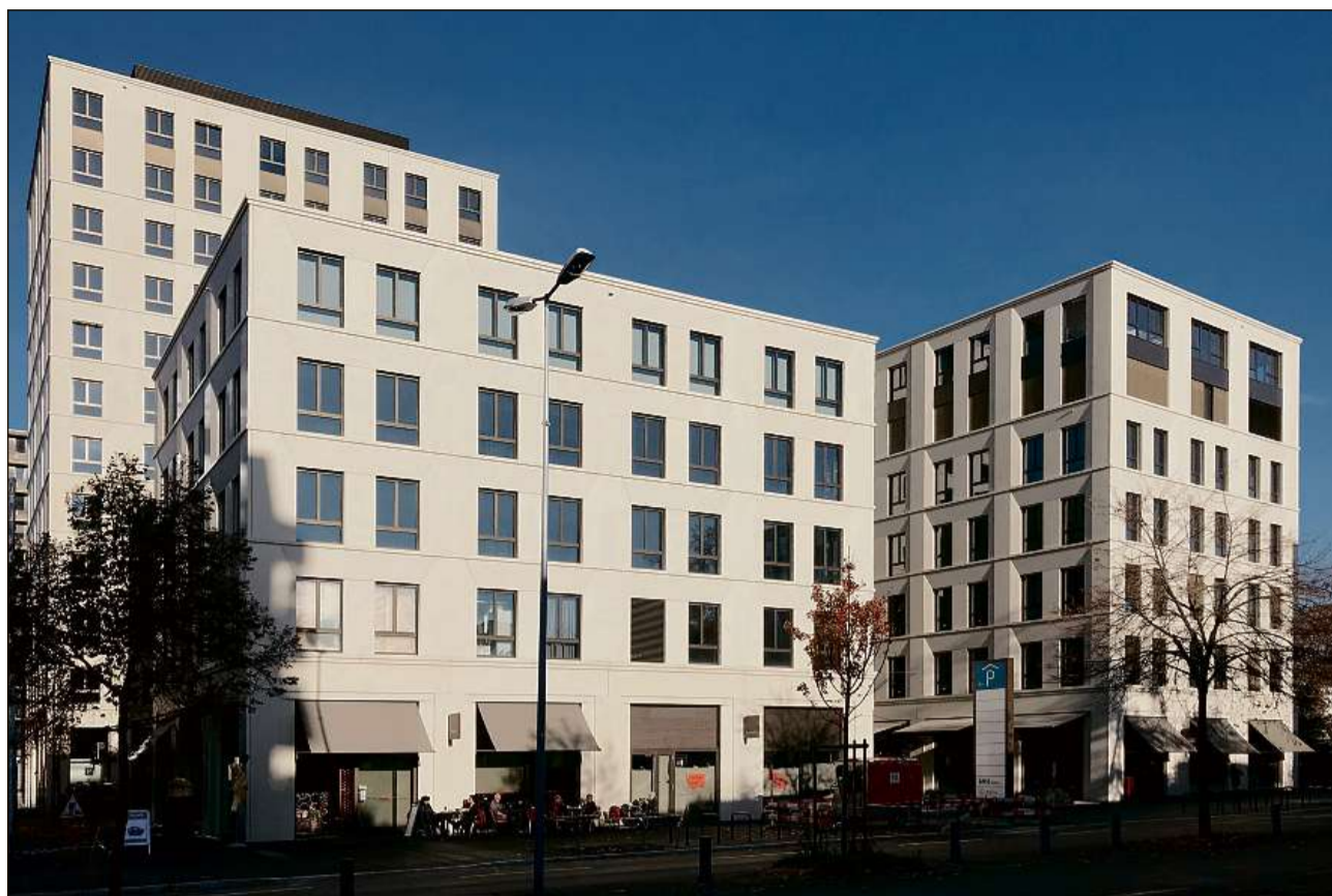
Surbajegiada sper la staziun ad Uster, realisada dal biro d'architectura ZSB nua ch'Arthur Loretz è schef da biro.
